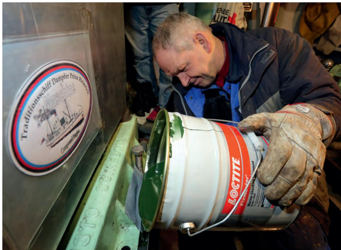
Fig. 4 - Secchio dopo secchio, la miscela viene versata negli stampi realizzati sotto i motori finché la cavità non è completamente riempita
