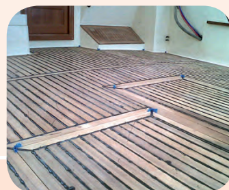
Calafataggio prima della carteggiatura con (foto sopra) e senza spatolatura (a sinistra)
